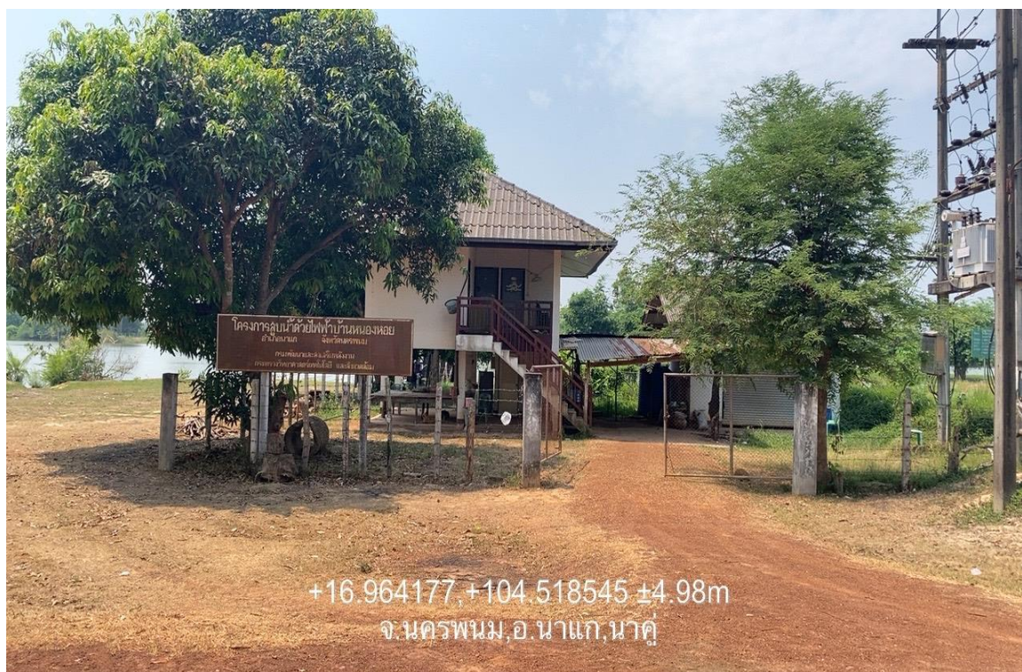
ภาพที่ 10 แสดงภาพคลองชลประทาน (คลองส่งน้ำ) คลองชลประทานตามโครงการสถานีสูบน้ำด้วยไฟฟ้า บ้านหนองหอยน้อย หมู่ที่ 1 ตำบลนาคู อำเภอนาแก จังหวัดนครพนม
